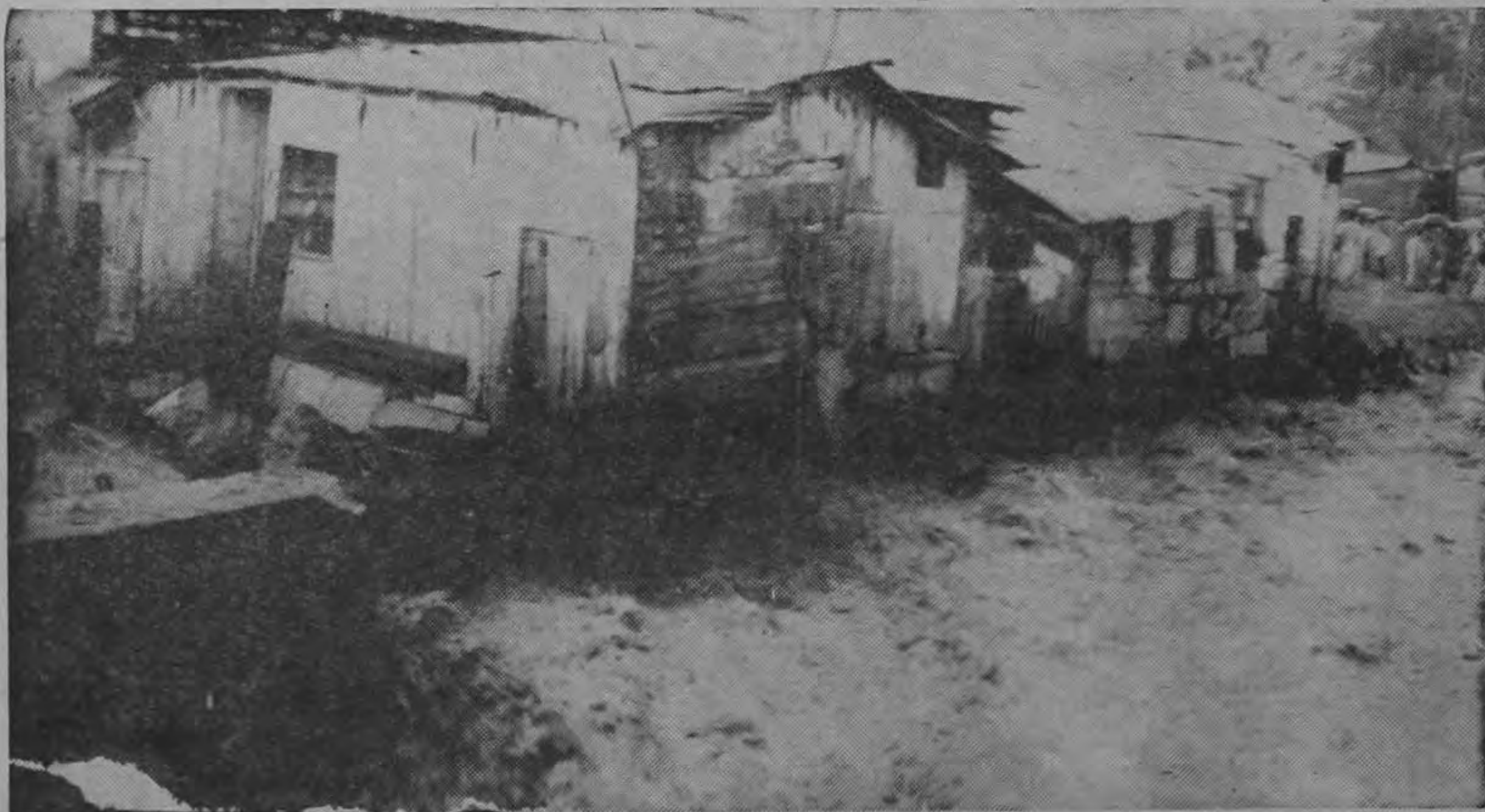
La furia de las corrientes del río Colorado iniciaron la destrucción de estas casitas. Sigue el agua, como se ve en la foto, arrasando sus cimientos.
