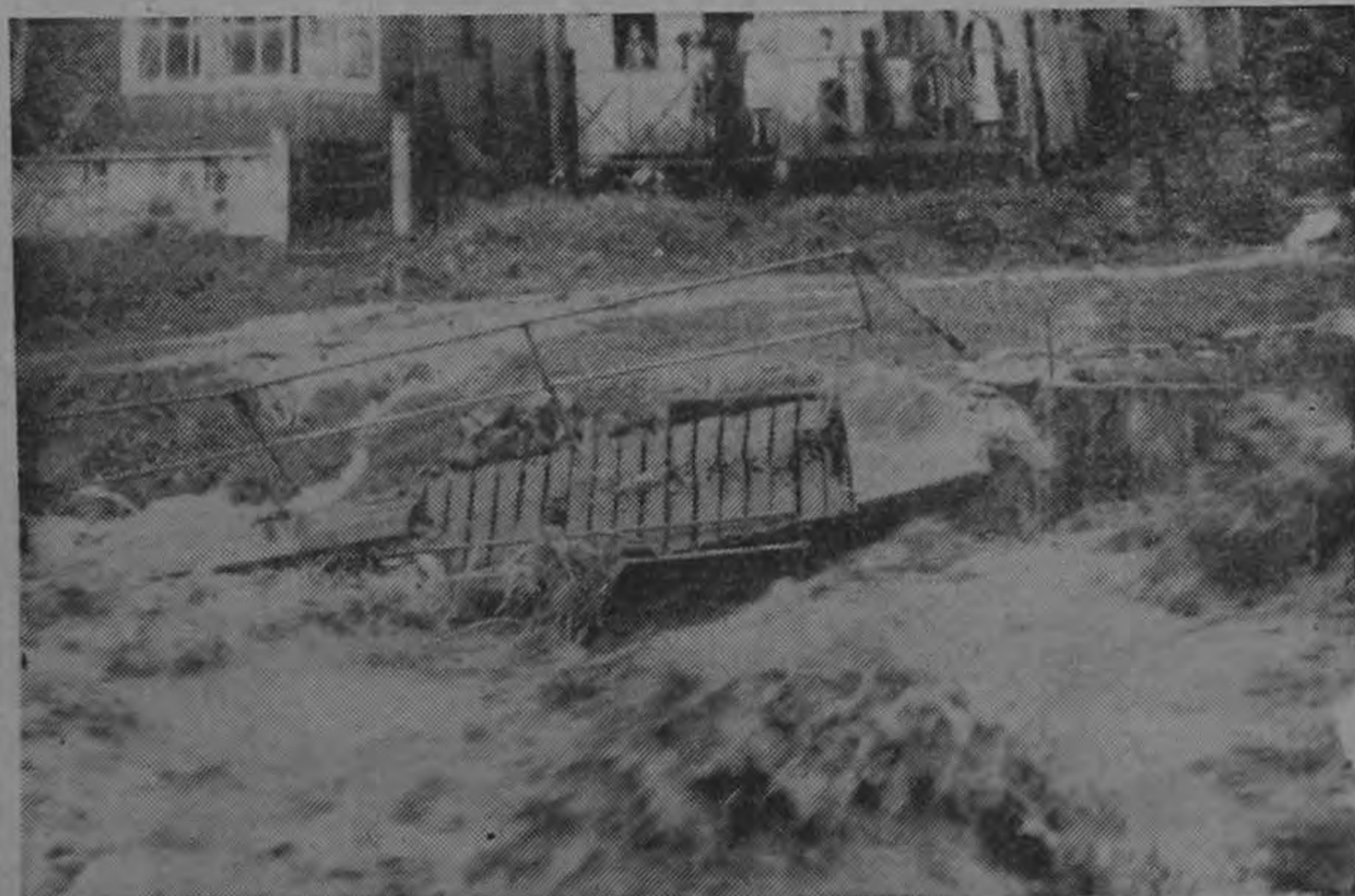
Restos del puente La Marimba sobre el río Colorado. El agua golpea con furia destruyendo todo a su paso. (Fotos de Hugo Araya)
